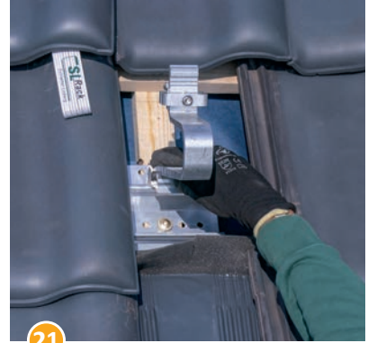
21 Dachhaken in Fuß einhängen.
