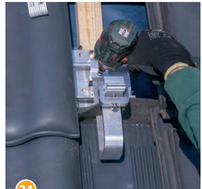
24 Position des Dachhakens durch Anziehen der Schraube fixieren (6 Nm).
