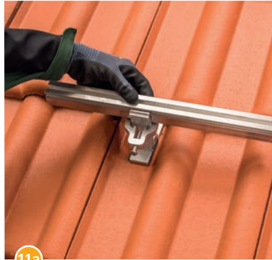
11a Die RAIL ausrichten und einhängen.
