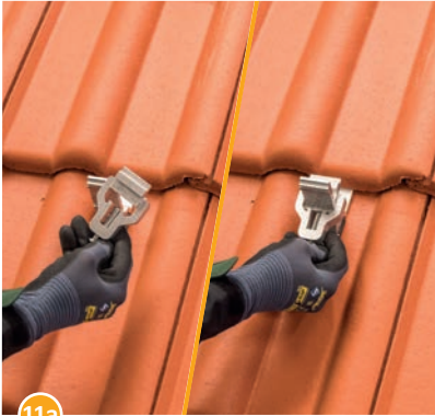
11a Die horizontale Klemmkombination auf die Stütze stecken.
