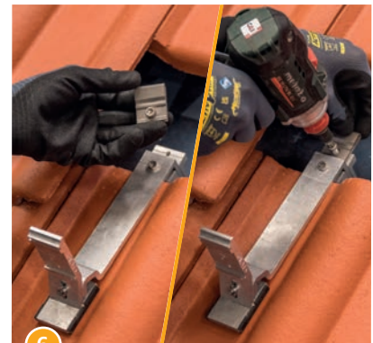
6 Die Potentialausgleichsklemme auflegen und die Schraube leicht anziehen.
