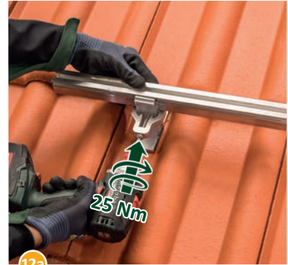
12a Die Klemmkombination mittels Schraube (10 Nm ± 0,5 Nm) festziehen - fertig!
