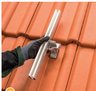
12b Die RAIL ausrichten und einhängen.
