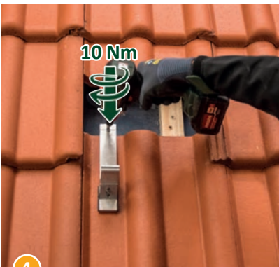
4 Die gewünschte Position durch Anziehen der Schraube (10 Nm \pm 0,5 Nm) auf dem Dachziegel fixieren.
