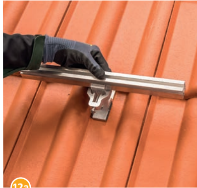
12a Die RAIL ausrichten und einhängen.
