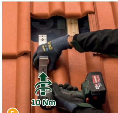
5 Die Stütze (10 Nm \pm 0,5 Nm) fest verschrauben.
