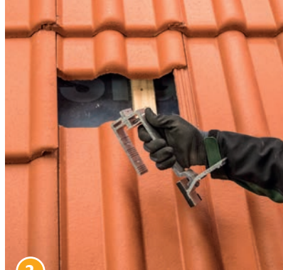
2 Den Haken unterhalb von Dachlatte...
