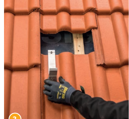
3 ...und Dachziegel einhängen.
