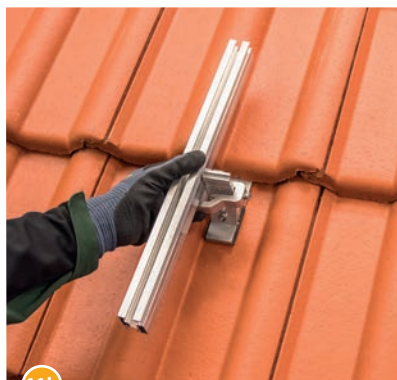
11b Die RAIL ausrichten und einhängen.
