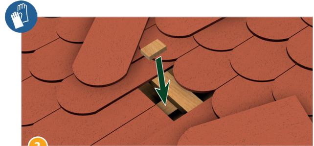
2 Legen Sie eine Unterlegplatte oder einen Holzkeil zum Höhen-
