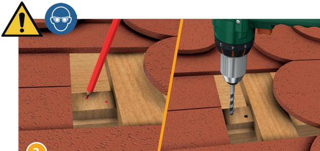
3 Bohren Sie die Befestigungslöcher mit einem Holzbohrer vor.
