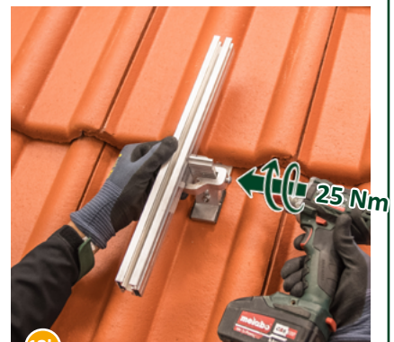
12b Die Klemmkombination mittels Schraube (25 Nm \pm 0,5 Nm) festziehen – fertig!
