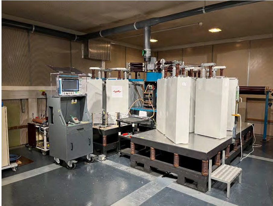
Bild 6: Elektrische Prüfung – Gesamtansicht des Aufbaus im 50 kA (10/350 µs) Impulsstrom Generator.
